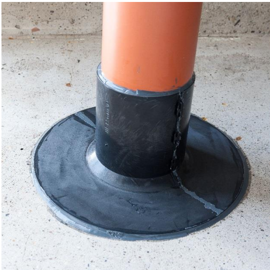
Düker Dichtflansch schwarz für Dachdurchführungen
